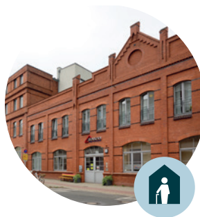
Neuendorfer Straße 75, Brandenburg an der Havel
